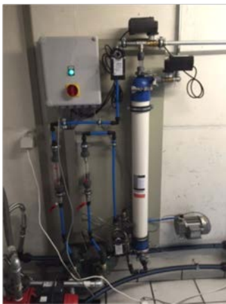
Beispiel für Installation einer Ein-Modul-Anlage
