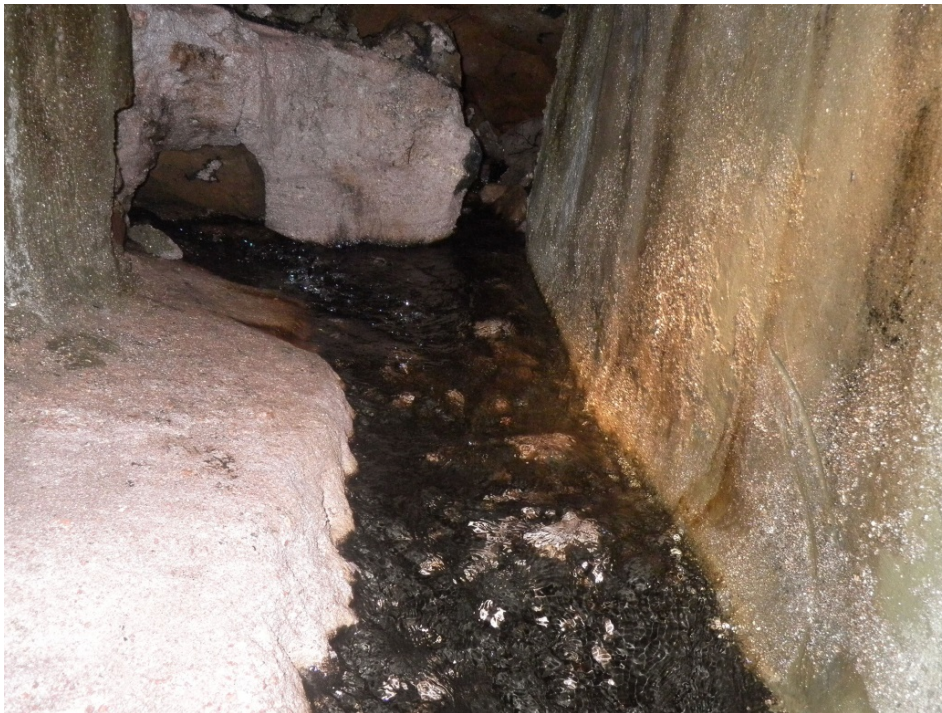
Bild 12: Fassung der Mühlbachquelle
