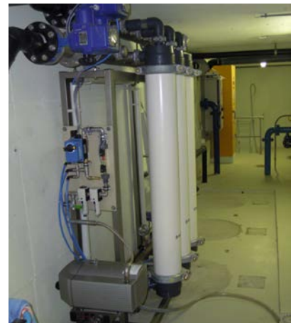
nach Installation der UF-Membran
