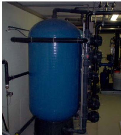
Räumlichkeiten des Wasserwerks vor Installation der Ultrafiltration
