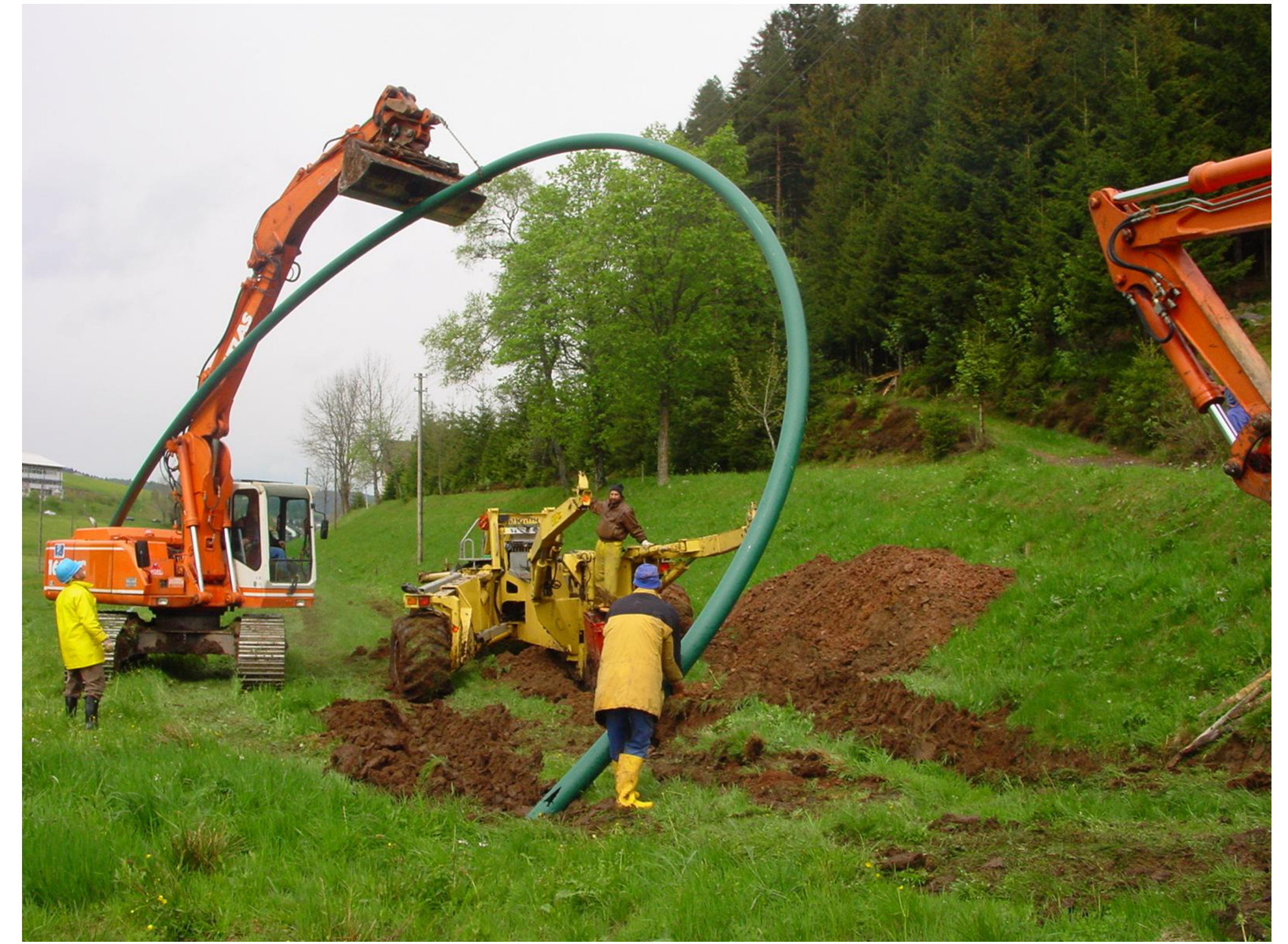
Einpfügen der Verbindungsleitung Furtwangen-Neukirch
