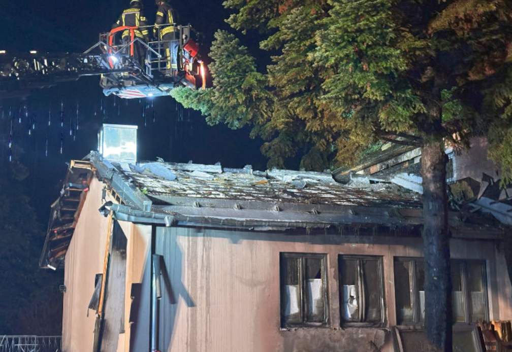
Teilgeöffnetes Dach mit sichtbarem mehrschichtigen Aufbau. Bildquelle: Feuerwehr Donaueschingen.
