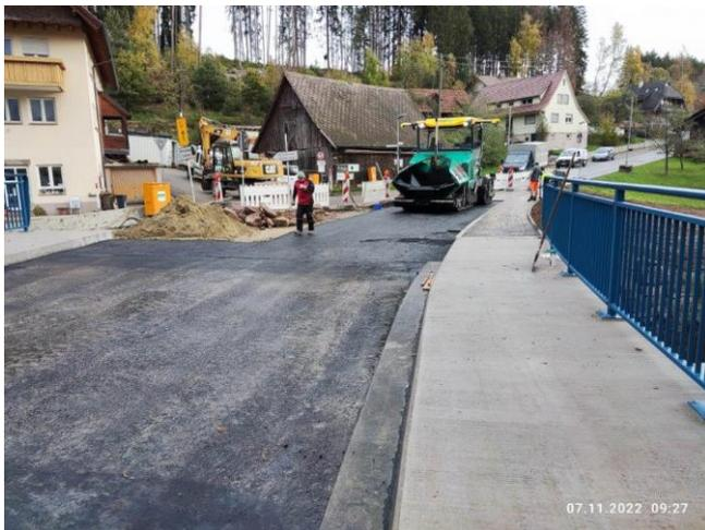
07.11.2022 Einbau der bituminösen Schichten
