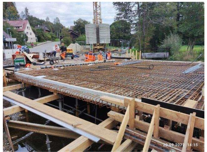
20.09.2022 Bewehrungseinbau Brückenplatte
