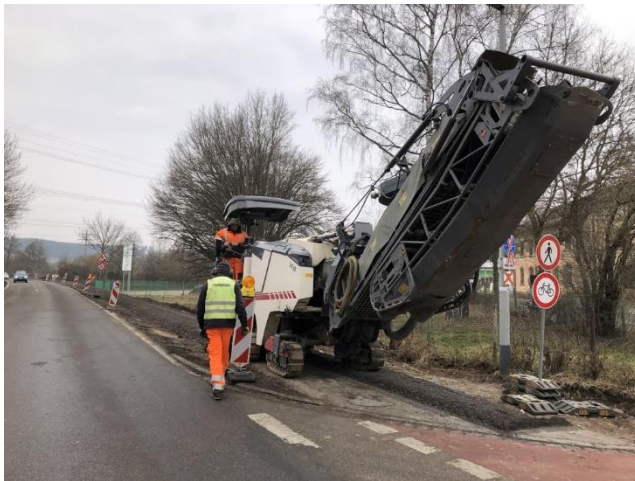
09.03.2023 Fräsarbeiten am bestehenden Radweg
