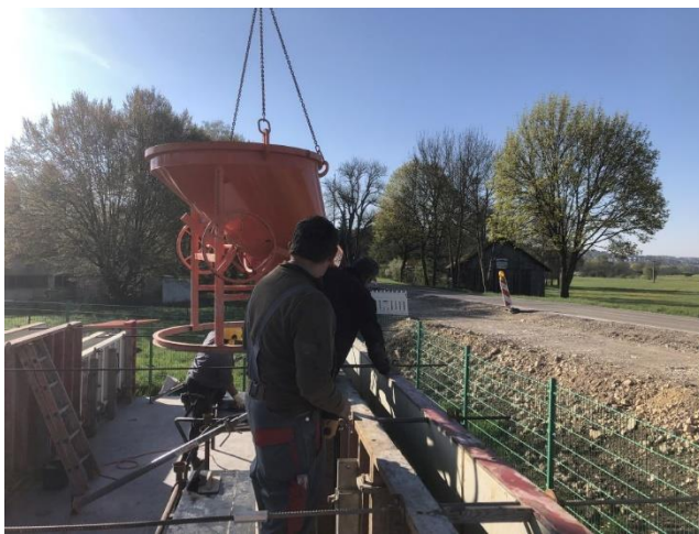
04.05.2023 Seitenwände betonieren
