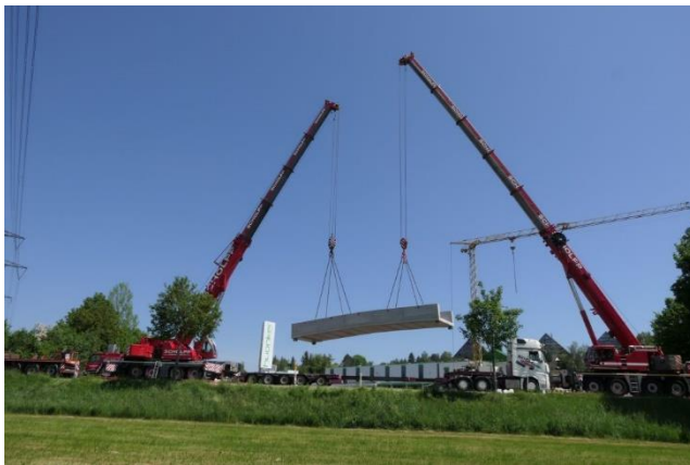
02.06.2023 Verladen der neuen Radwegbrücke auf einen Tieflader
