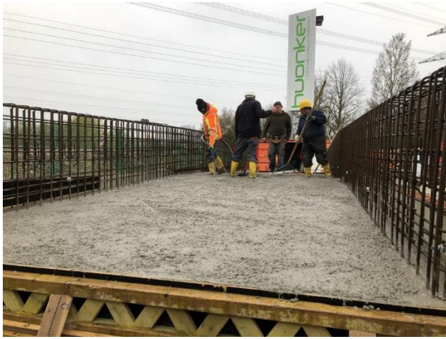
25.04.2023 Überbau betonieren
