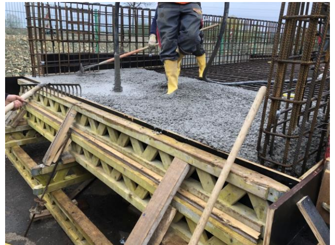
25.04.2023 Überbau betonieren
