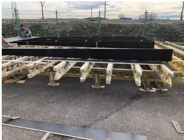
21.03.2023 Beginn der Schalarbeiten für die neue Radwegbrücke
