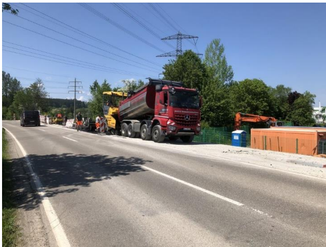
30. + 31.05.2023 Einbau der Bituminösen Schichten
