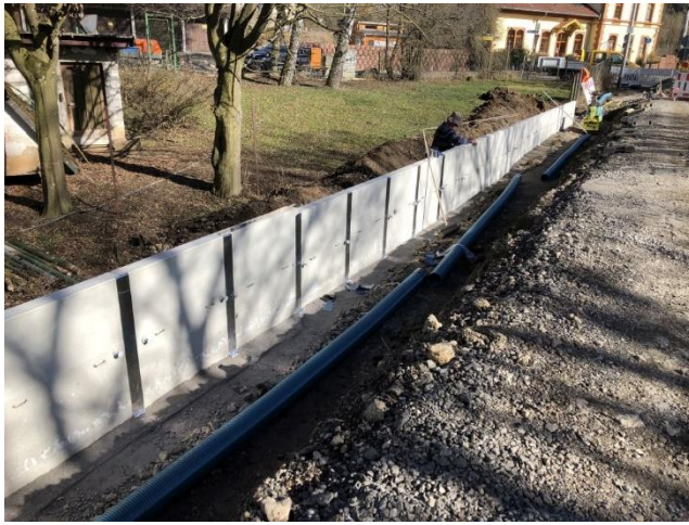
16.03.2023 Mauerscheiben gesetzt Bereich Bauende
