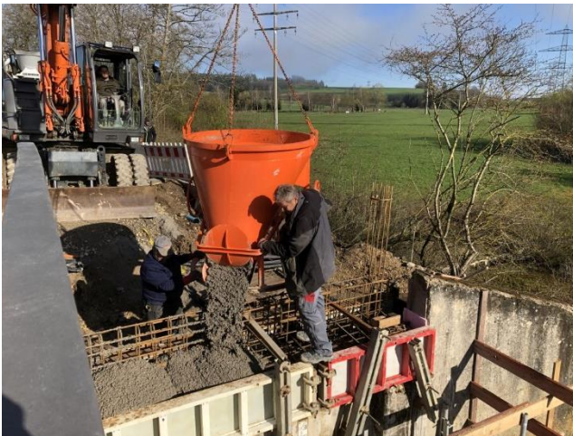
21.04.2023 Wiederlager betonieren
