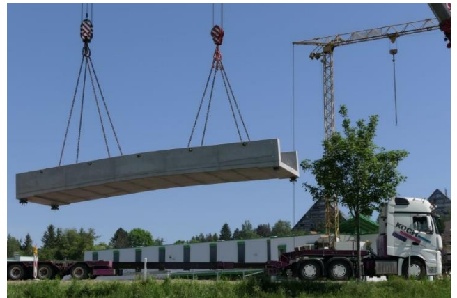
02.06.2023 Verladen der neuen Radwegbrücke auf einen Tieflader
