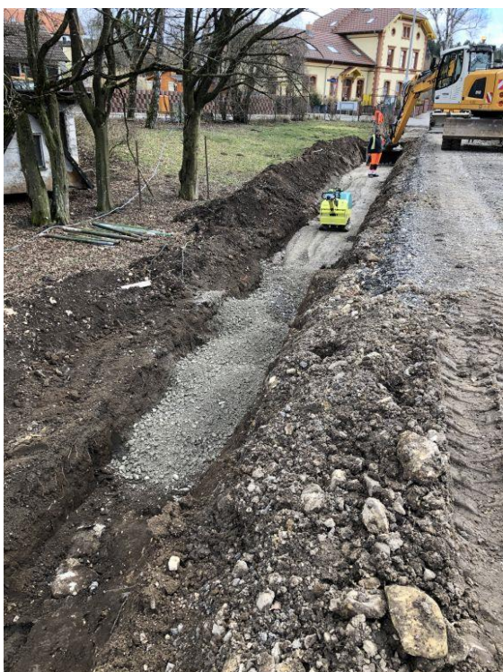
09.03.2023 Erdarbeiten für Mauerscheiben Bereich Bauende
