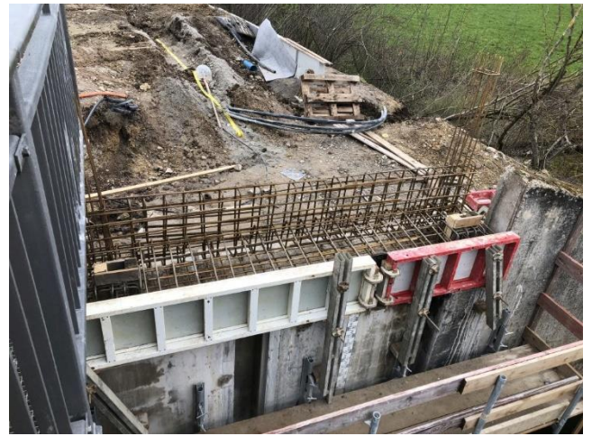
18.04.2023 Bewehrungseinbau Wiederlager
