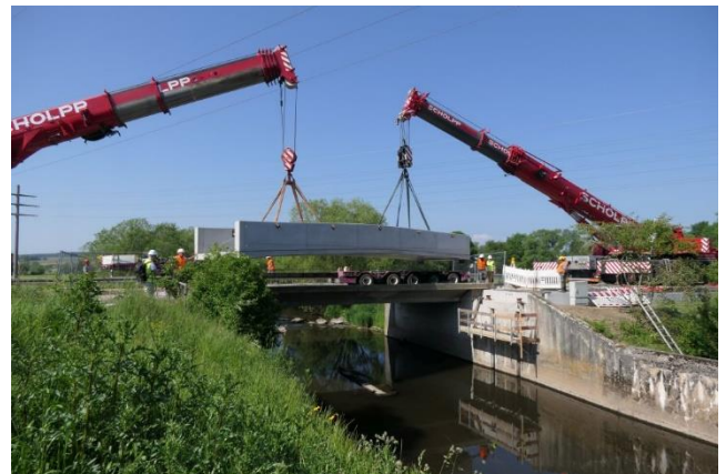
02.06.2023 Verladen der neuen Radwegbrücke auf einen Tieflader
