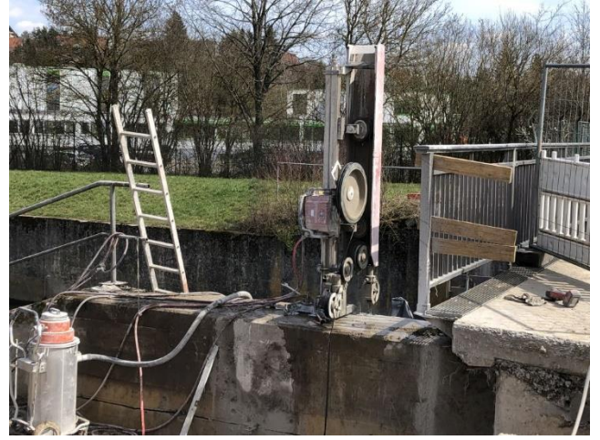
06.04.2023 Teilweise Abtrennen der bestehenden Betonwände für die neuen Wiederlagerbänke
