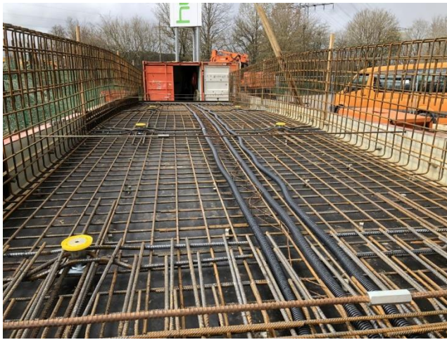
13.04.2023 Bewehrungseinbau Überbau
