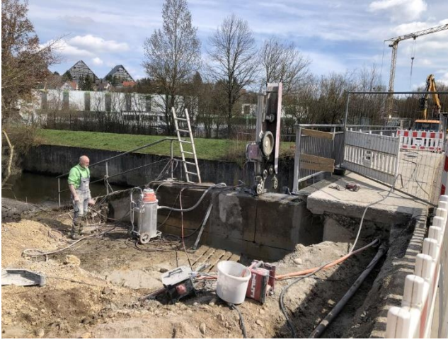
06.04.2023 Teilweise Abtrennen der bestehenden Betonwände für die neuen Wiederlagerbänke
