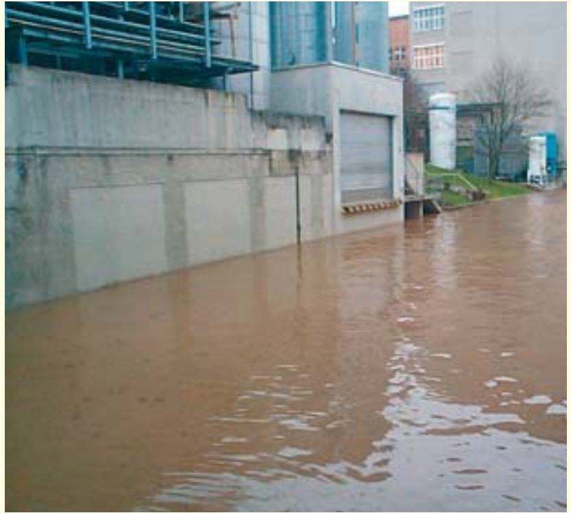
Betriebsteil bei Hochwasser
