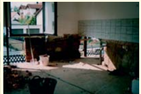
Mauerwerksaustausch infolge Ölverschmutzung (Kelheim 1999)
