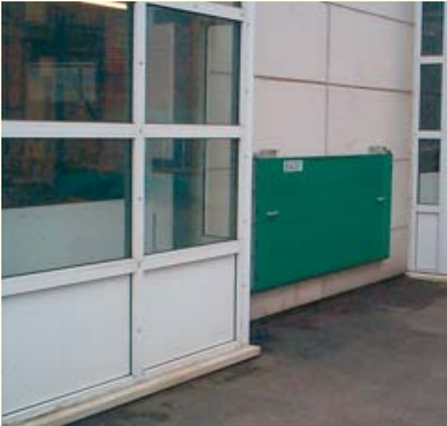
Gebäude werden durch mobile Barrieren an den Eingängen geschützt
