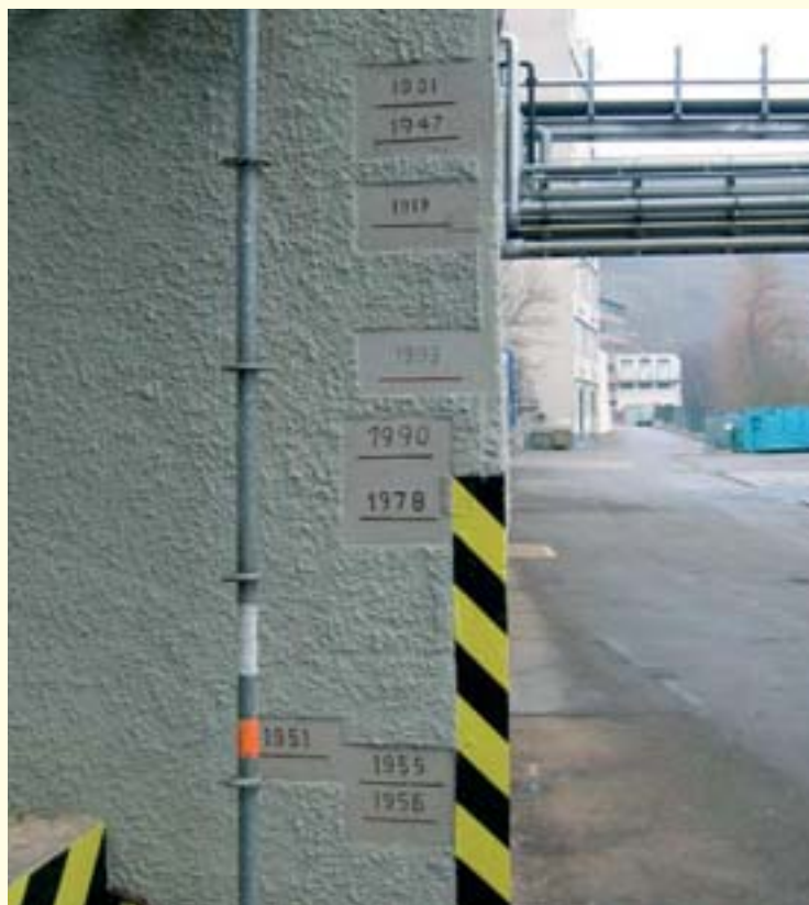
Zur Aufrechterhaltung des Hochwasserbewusstseins sind an markanten Stellen historische Hochwasserstände markiert
