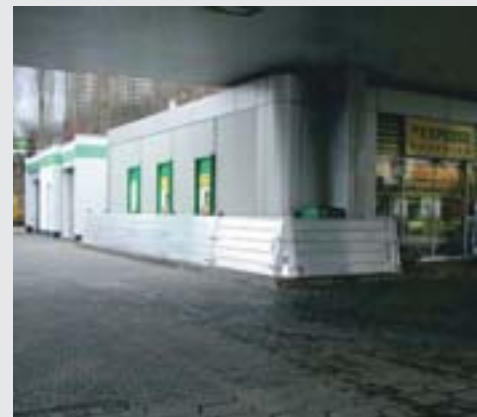
Kombination von dauerhafter und mobiler Abschirmung an einer Tankstelle
