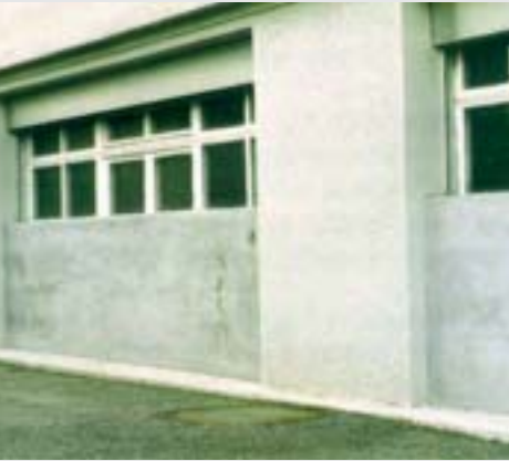
Abdichtung von Öffnungen (permanent) durch Vormauer
