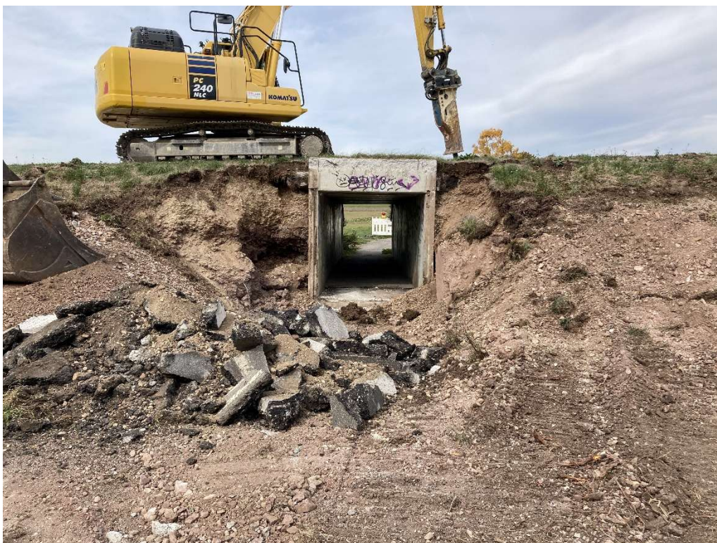
Abbrucharbeiten/Rückbau Fuß- und Radwegunterführung.
