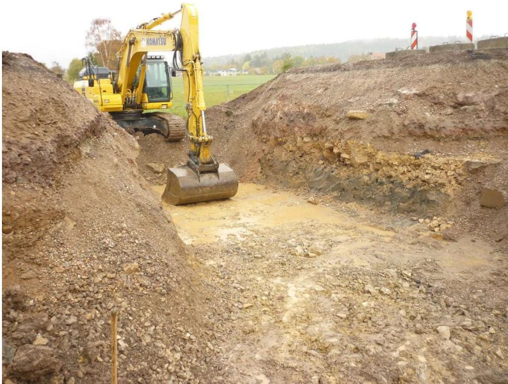
Baugrube nach rückgebauter Unterführung.
