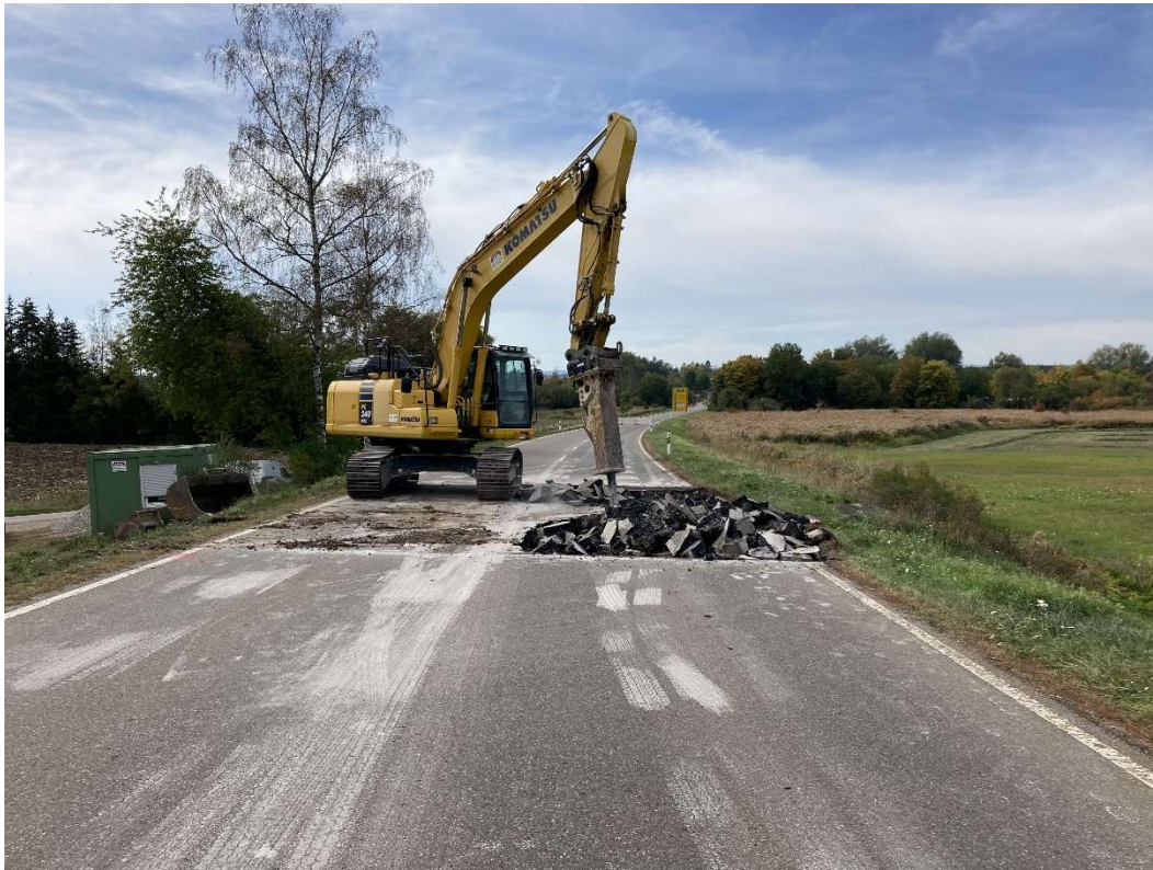
Straßenasphalt Aufbruch Arbeiten.
