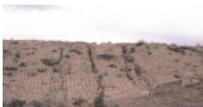
*Erosionsrinnen an der Böschung einer Geländeauffüllung*
