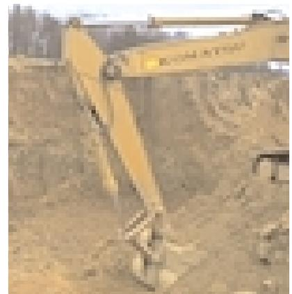
Ausbau von ausreichend abgetrocknetem Lößlehm mit dem Hydraulikbagger
