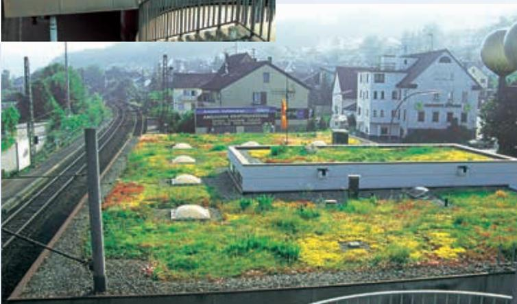
Vom Kiesdach zum extensiven Gründach im Zuge einer Dachsanierung [Bild: DDV]
