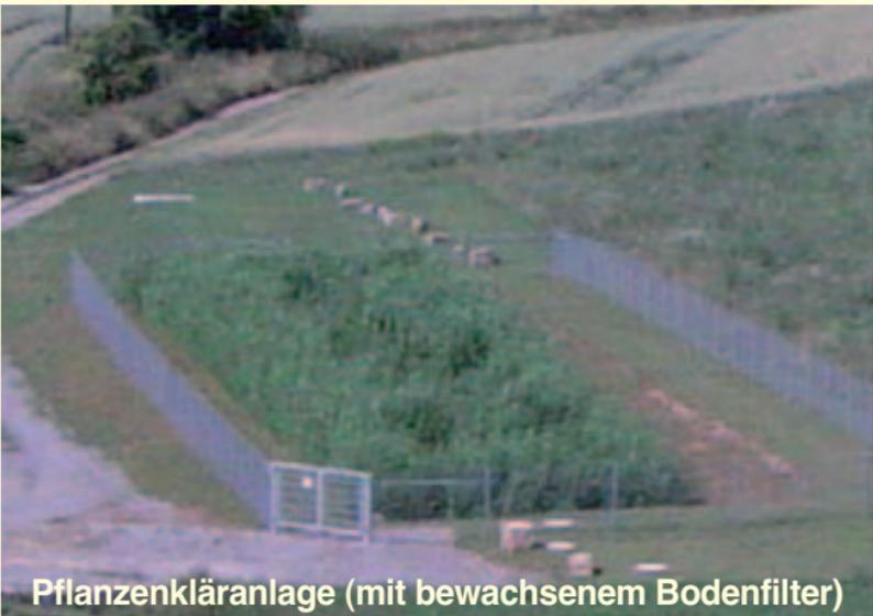
Pflanzenkläranlage (mit bewachsenem Bodenfilter)
